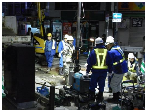
夜間工事風景、1件1件の工事に 企業の死活がかかる
