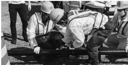
亀裂部分に特殊継手を取り付けて止水
