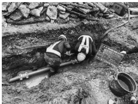
志賀町で漏水修理を行う神奈川協組
