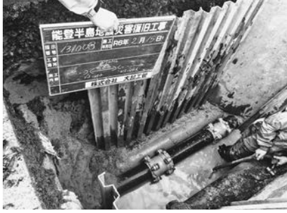
水道管の漏水を修繕(株大起管工提供)
