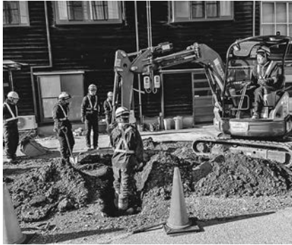
クレーン車による掘削作業(みやび管工提供)
