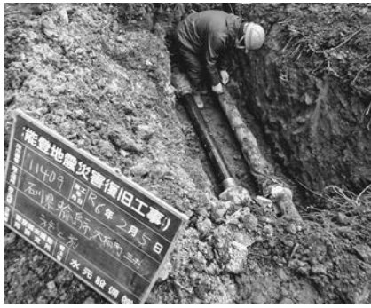
輪島市で復旧工事に奮闘(水元設備提供)
